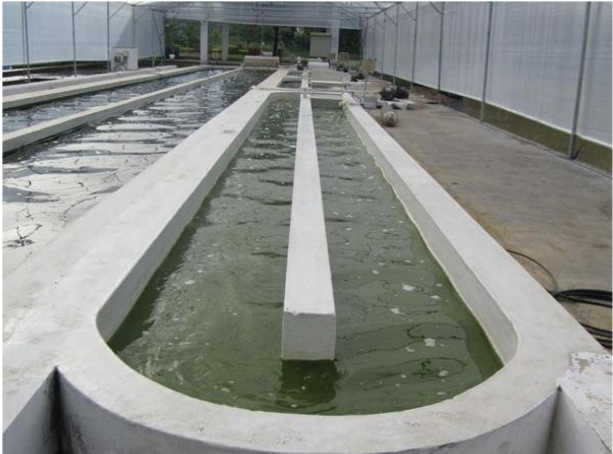
Рис. 1. Контактні резервуари – відстійники
